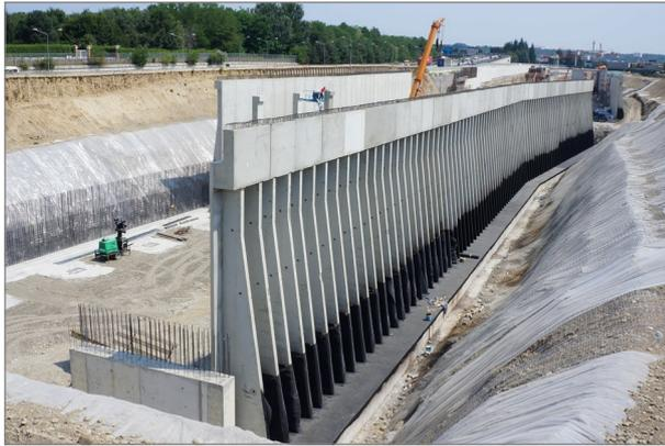
apportate dal nostro elemento sono di tipo tecniche ma soprattutto economiche. Con il nuovo sistema infatti il peso proprio dell'impalcato è caricato direttamente sugli elementi prefabbricati e non sul terreno adiacente al muro. Questo comporta una sensibile riduzione del costo della struttura, poiché si riduce oltre la lunghezza dell'impalcato, anche il getto in opera e le armature della stessa
