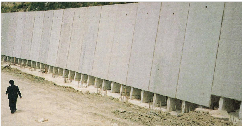
MUR EN BÉTON APPARENT
