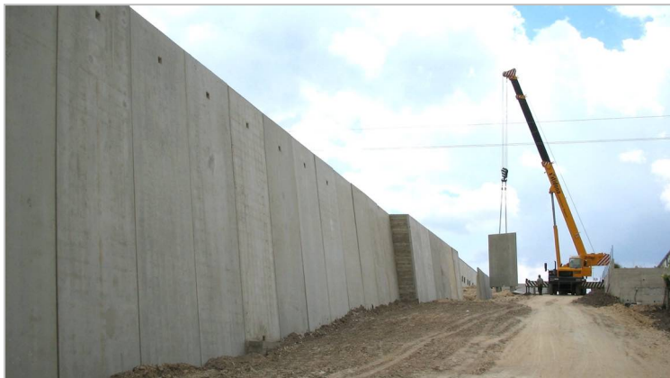
MURO FACCIAVISTA IN CEMENTO
