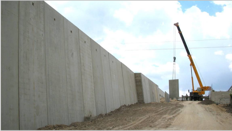
MURO HORMIGÓN VISTO
