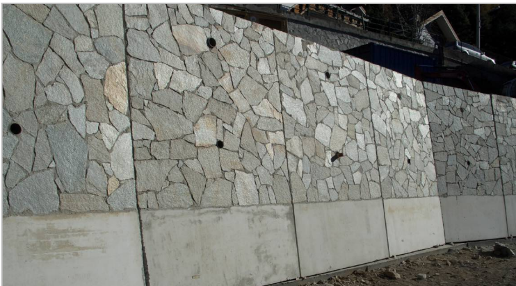
MURO ACABADO DE PIEDRA
