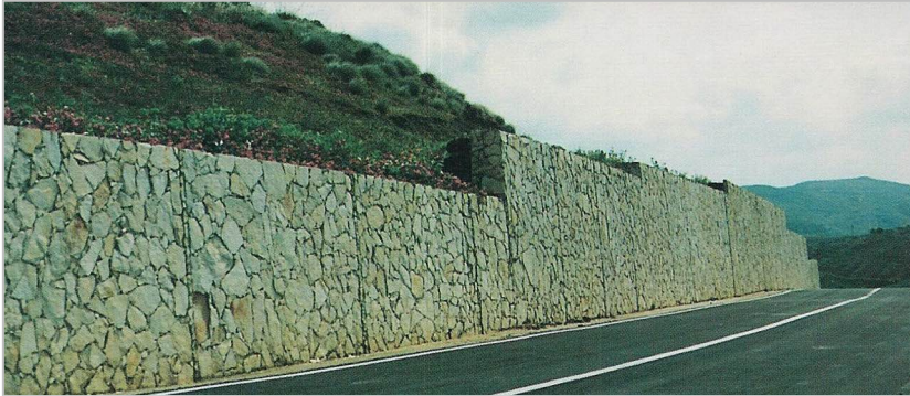
MURO ACABADO DE PIEDRA
