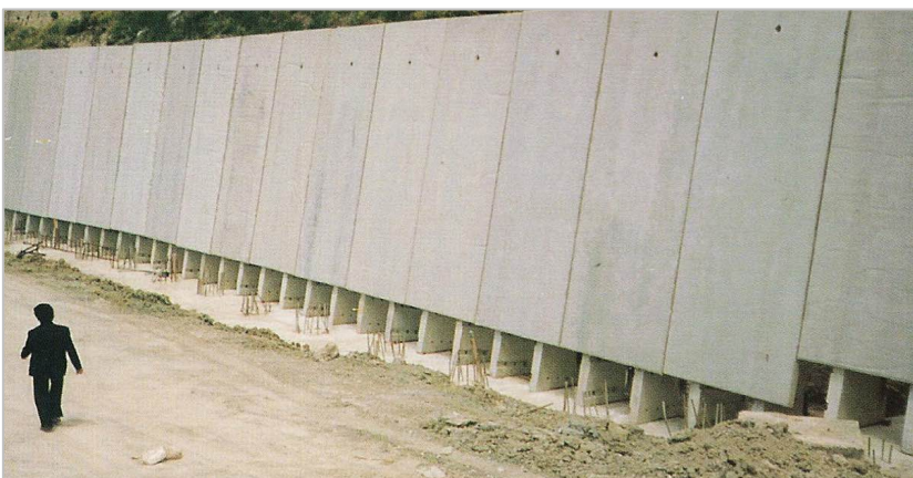
MURO HORMIGÓN VISTO
