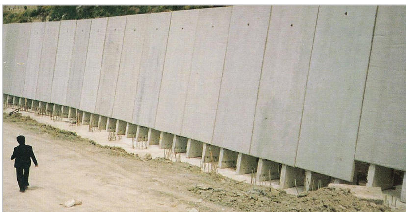
MURO FACCIAVISTA IN CEMENTO
