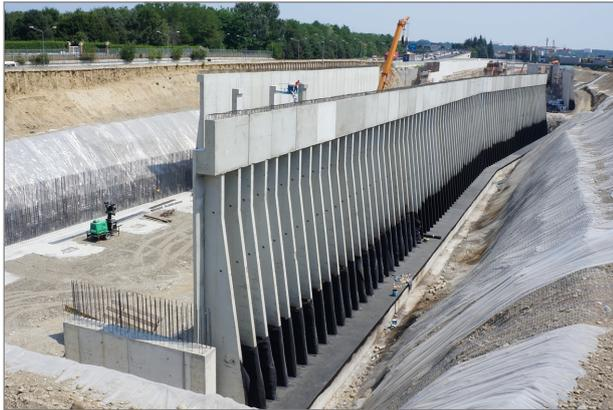
técnicas, pero principalmente económicas. De hecho, con el nuevo sistema, el peso de la cubierta se carga directamente en los elementos prefabricados y no en el terreno adyacente al muro. Esto implica una considerable reducción del gasto de la estructura, ya que se reduce, además de la longitud de la cubierta, también colocación del hormigón en obra y las
