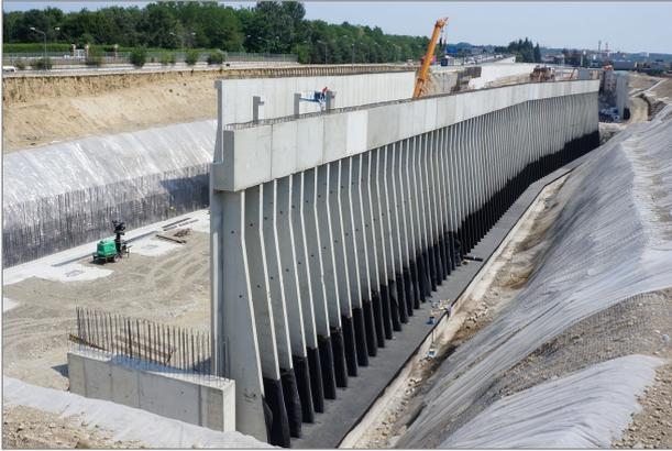
marché. Les principales améliorations apportées par notre élément sont techniques, mais surtout économiques. Par la nouvelle méthode le poids du pont s'appuie directement sur les éléments préfabriqués, non plus sur le sol adjacent au mur. Cela entraîne une réduction considérable du coût de la structure puisque on
